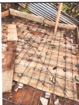
Foto 3: Reparación Losa de Patio
