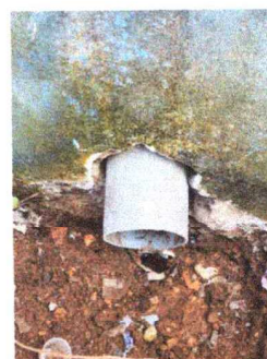
Foto 4: Reparación de cuneta de concreto
