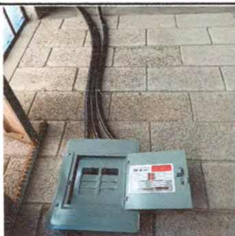
Foto 5: Toda la instalación eléctrica fue cambiada y también se coloca una nueva caja de filipones.
