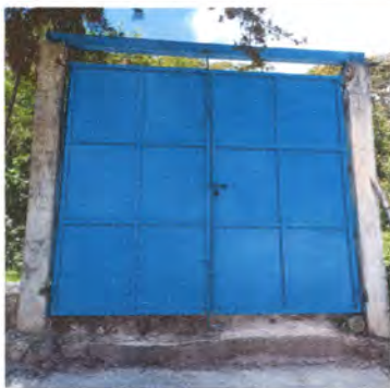
Foto1: Se puede observar el portón ya instalado
