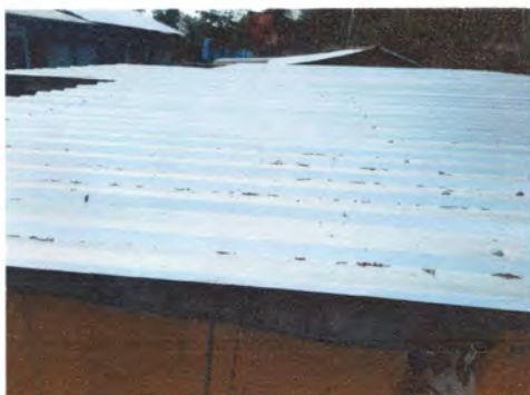
Foto 3: El techa cambiado en tu totalidad
