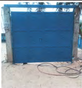
Foto1: Se puede observar que el proceso de instalación del portón
