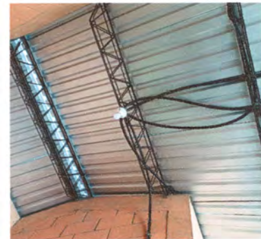
Foto 4: se observa que la estructura fue colocada para colocar la nueva lámina y también que ya se está colocando la luz dentro de unas aulas.
