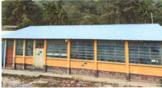
Foto1: El techo ya fue cambiado de algunas aulas.
