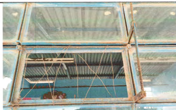
Foto4: Se puede observar falta de vidrios y ventanales en mal estado
