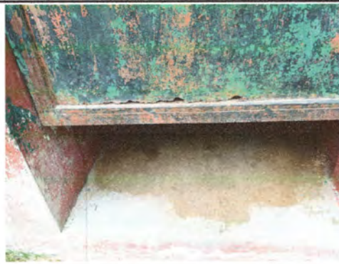
FOTO 2: Se puede observar que las puertas de los baños se encuentran ya picadas y no cierran totalmente
