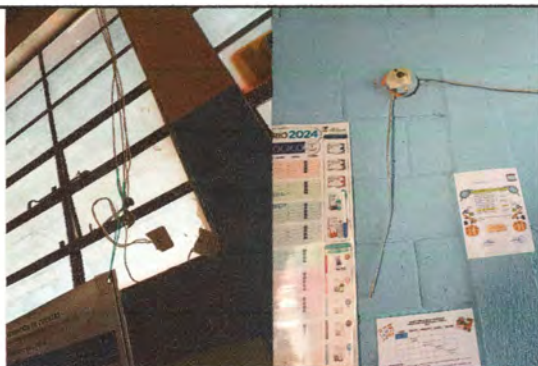
Foto 5: Se puede evidenciar la falta de energía eléctrica en algunas aulas y en otros salones las instalaciones ya se encuentran deterioradas
