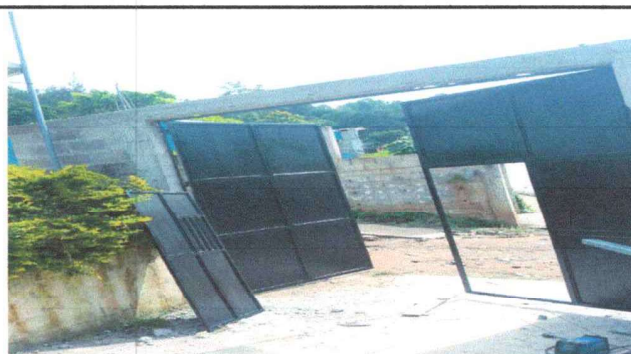
Foto 4: CAMBIO DE PORTON
