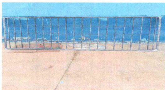
Foto 3: CAMBIO DE VENTANA
