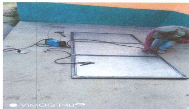
FOTO 2: RENOVACION DE PUERTA
