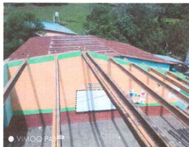
FOTO; CAMBIO DE TECHO EN PROCESO
