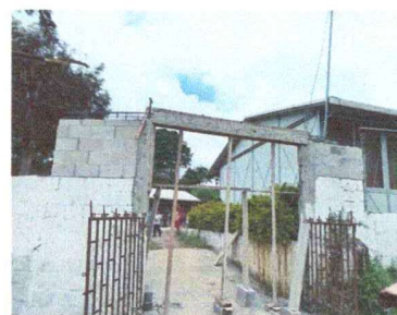
Foto 4: PORTON EN REMODELACION
