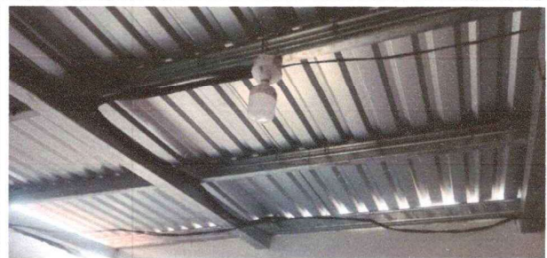
Foto 6: cambio de estructura de techo finalizado
