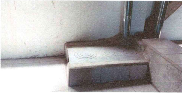
Foto 1. Area de cocina. instalacion de plancha de metal finalizado
