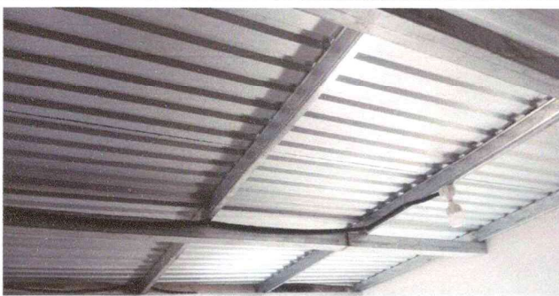
Foto 5: cambio de cubierta de lámina finalizado
