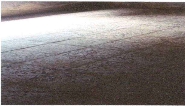
Foto 3: reparación de piso finalizado
