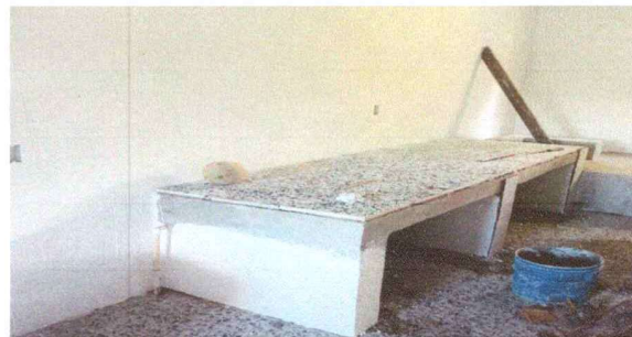
Foto 2: area de cocina cubierta de piso y ceramico en proceso.
