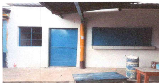
Foto 4: pintura de puerta y ventana en proceso
