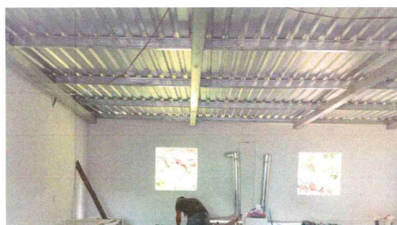
Foto 6: cambio de estructura de techo en proceso
