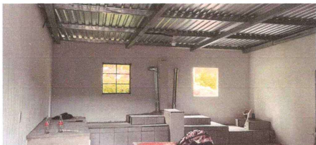
Foto 1: Area de cocina. Reconstrucción de pollo de cocina e instalación de plancha de metal en proceso
