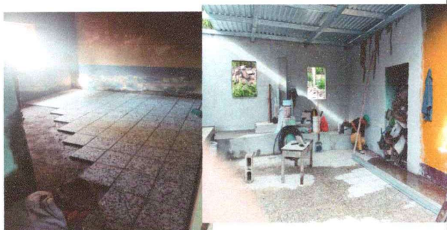
Foto 3: reparación de piso en proceso
