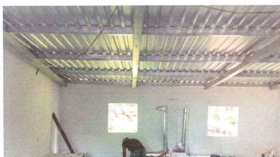
Foto 5: cambio de cubierta de lámina en proceso
