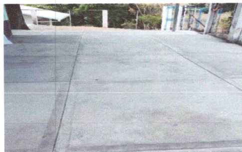
FOTO 6: Mantenimiento a losa de patio.
