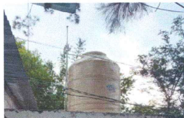
FOTO 2: Mantenimiento y reparación de sistema de agua, rotoplas.
