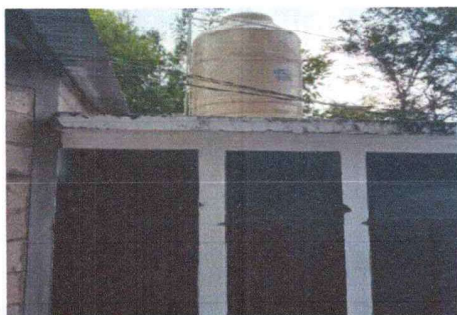
FOTO 3: Reparación y mantenimiento de sanitarios.
