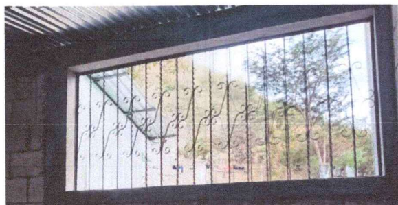
FOTO 5: Instalación de ventana.
