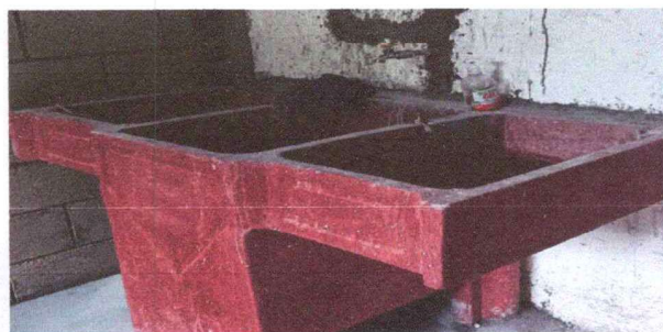
FOTO 4: cambio y mantenimiento de sistema de agua potable y cambio de pila.
