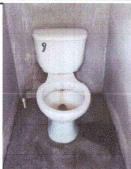
Foto1: Mantenimiento y reparación de servicios sanitarios
