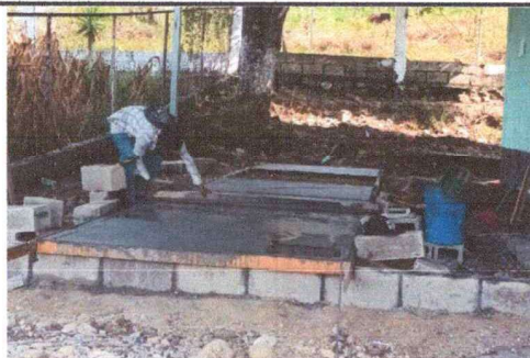
Foto 5: Trabajo realizado en primer área de losa de patio.
