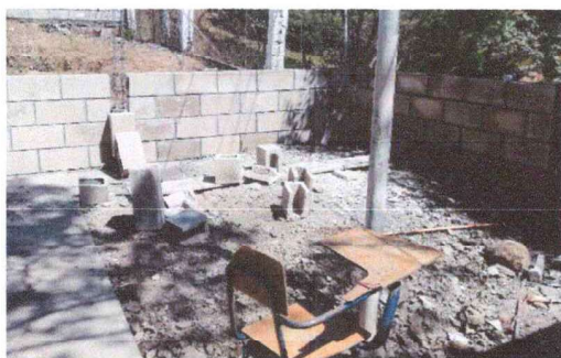
Foto 3: sustitución del área de cocina.
