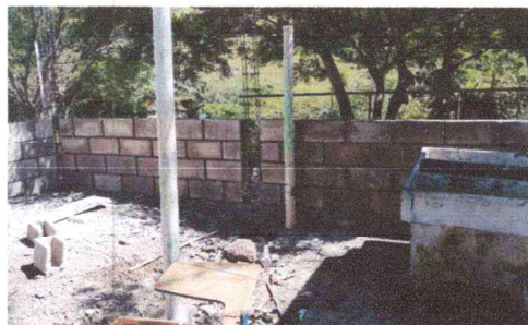
Foto 2: Sustitución del área de cocina.
