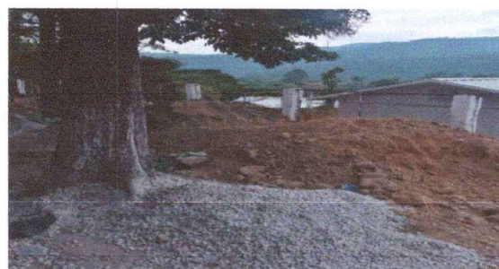
Foto 6: Segunda área de losa de patio.
