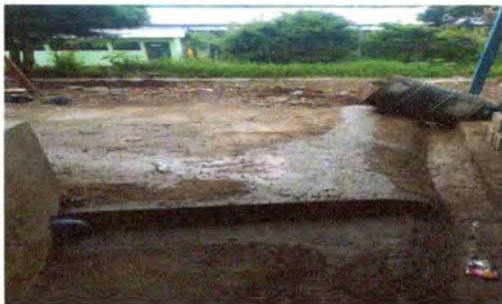
Foto 5: REPARACION DE DRENAJES Y RED DE AGUA
