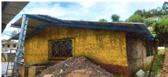
Foto1: CUBIERTA DE TECHO (desmontaje de lamina, instalacion de lamina troquelada calibre26)
