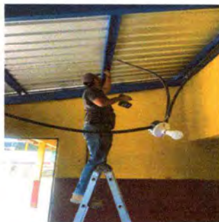
Foto 7: SISTEMA ELECTRICO (cableado e instalacion de lamparas)
