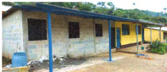
Foto 2: ESTRUCTURA DE TECHO (tubos de 4*4 costanera de 3*2)
