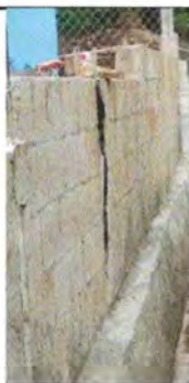
Foto 9: MURO PERIMETRAL (block con sistema pineado)
