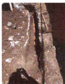
Foto 5: REPARACION DE DRENAJES Y RED DE AGUA
