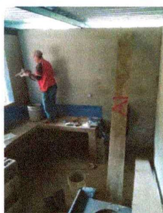
Foto 3: REPARACION O SUSTITUCION EN AREA DE COCINA ( repello y cernido en direfentes areas, estufas rurales, meson)
