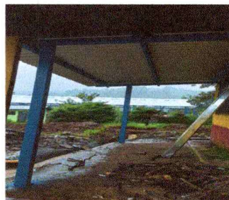
Foto 2: ESTRUCTURA DE TECHO (tubos de 4*4 costanera de 3*2)
