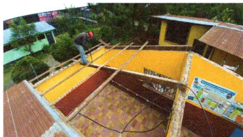
Foto1: CUBIERTA DE TECHO (desmontaje de lamina, instalacion de lamina troquelada calibre26)
