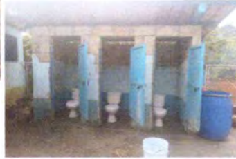
Foto7: SE OBSERVA CAMBIO TOTAL DE LETRINAS E INSTALACION DE BIOSEPTICO
