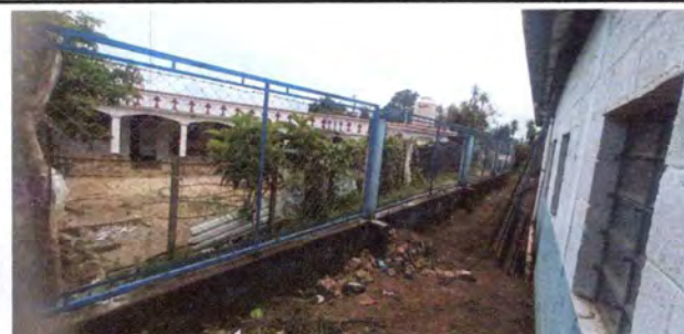
Foto 4: SE APRECIA EL CAMBIO DE LA MALLA Y SU ANCLAJEA DE MURO.
