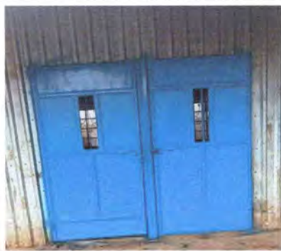
Foto 3: SE OBSERVA REPARACION DE PUERTAS DE AULAS
