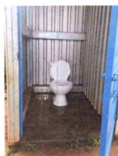
Foto 6: SE OBSERVA CAMBIO DE SANITARIOS
