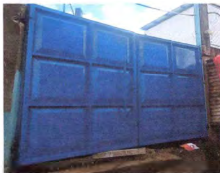
Foto 1: SE OBSERVA EL CAMBIO DEL PORTÓN
