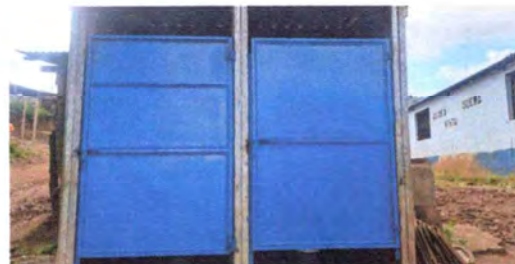
Foto 2: SE OBSERVA REPARACIÓN DE PUERTAS DE SANITARIOS
