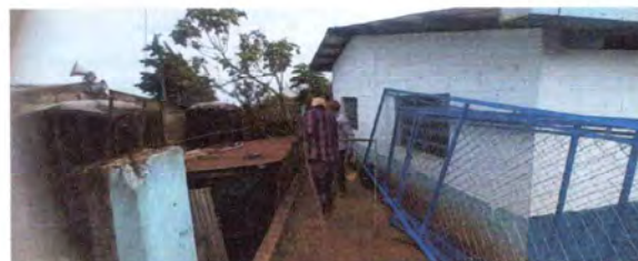
Foto 4: SE OBSERVA CAMBIO DE MALLA Y SU ANCLAJE
