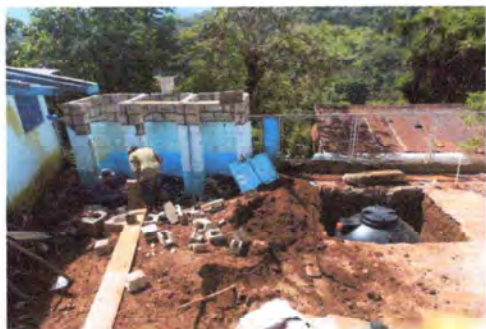
Foto7: SE OBSERVA CAMBIO DE DRENAJE Y SUSTITUCION POR BIOSEPTICO
