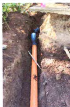
Foto 6: SE OBSERVA REPARACIÓN DE DRENAJE Y SANITARIO
