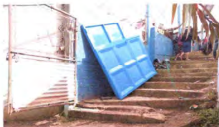
Foto1: SE REALIZA EL RESPECTIVO CAMBIO DEL PORTÓN
