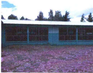
Foto 1 Cambio de Cubierta
