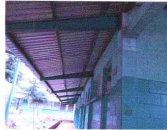
Foto 2 Estructura de Techo
