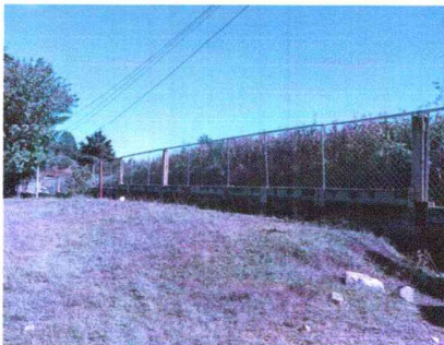
Foto 5: Cambio de malla
