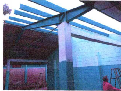
Foto 2 Estructura de Techo
