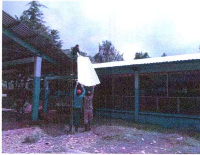
Foto 1 Cambio de Cubierta
