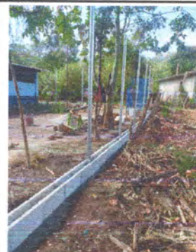
Foto 4: INSTALACIÓN DE MURO PERIMETRAL CON BASE DE BLOCK E INSTALACIÓN DE MAYA.
