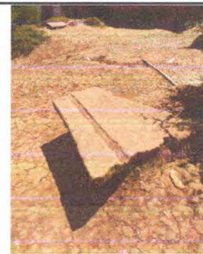
Foto 6: Torta de cemento de patio en malas condiciones.
