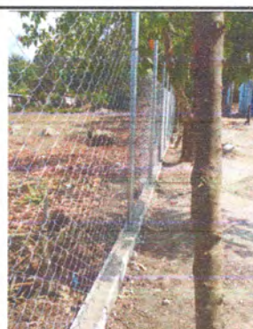
Foto 4: FINALIZACIÓN DE CIRCULACIÓN DE PERÍMETRO CON MAYA Y BASE DE BLOCK.
