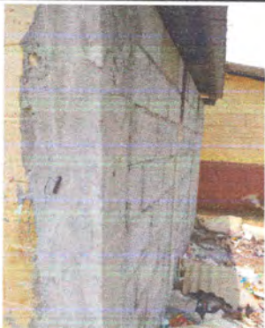
Foto 1: FINALIZACIÓN DE CONSTRUCCIÓN DE PARED DE SANITARIOS.
