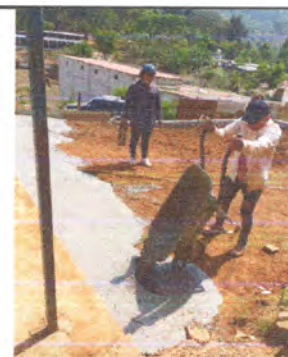
Foto 6: SUSTITUCIÓN DE TORTA DE CEMENTO EN PATIO.
