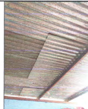
Foto 2: Techo de salón con goteras, debido a la perforación de lámina.
