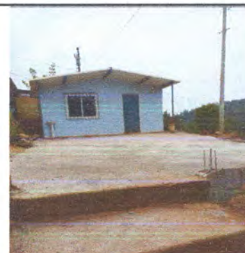
Foto 6: FINALIZACIÓN DE TORTA DE CEMENTO EN PATIO..
