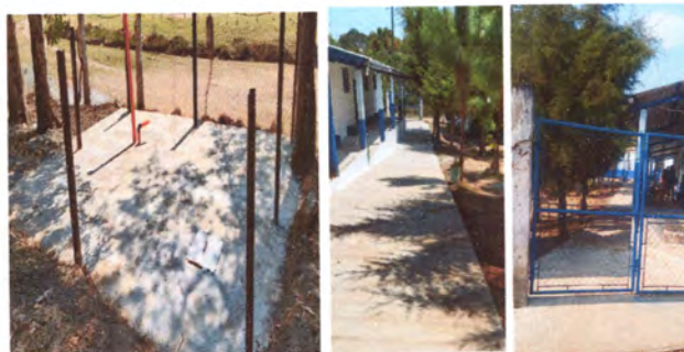
Foto 6: Reparación de drenajes y losa de patio
