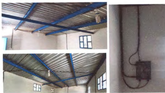
Foto 5: Reparación de Sistema Eléctrico
