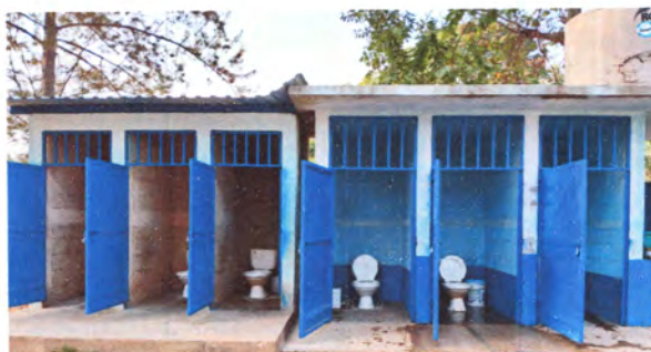
Foto 4: Reparación de servicios sanitario y sus accesorios
