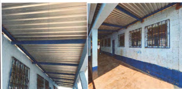
Foto 2: Cambio de Estructura de Techo
