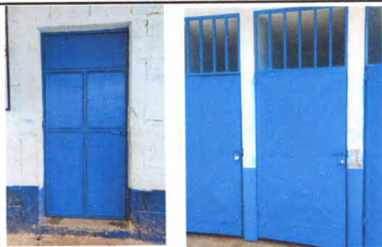
Foto 3: Reparación de Puertas
