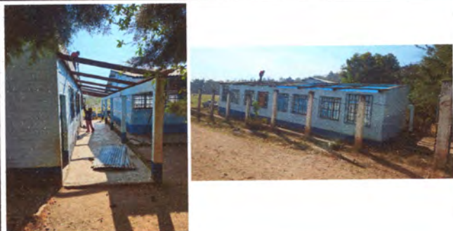
Foto1: Cambio de Lámina
