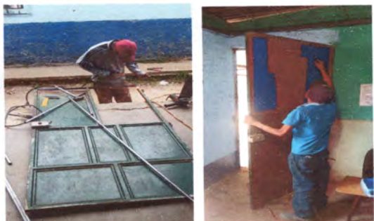
Foto 3: Reparación de Puertas
