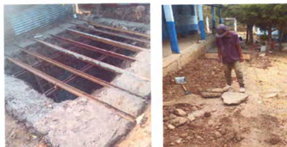
Foto 6: Reparación de drenajes y losa de patio
