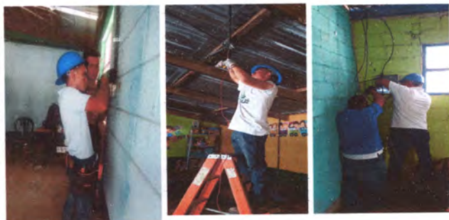
Foto 5: Reparación de Sistema Eléctrico
