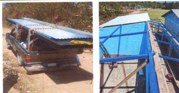
Foto 2: Cambio de Estructura de Techo
