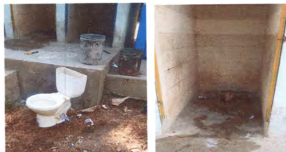
Foto 4: Reparación de servicios sanitario y sus accesorios
