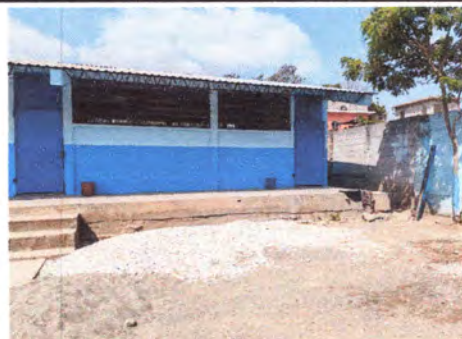
FOTO 2: Pintado de Paredes
