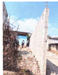
Foto 6: Reparación de muro perimetral
