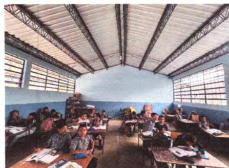
Foto4: Cambio de techo
