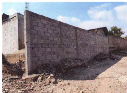
Foto 5: Reparación de muro perimetral
