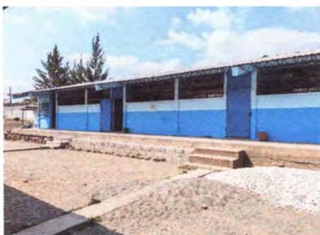
Foto1: Pintado de paredes
