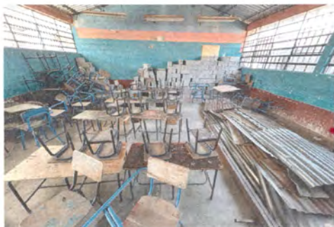
Foto3: Cambio de techo
