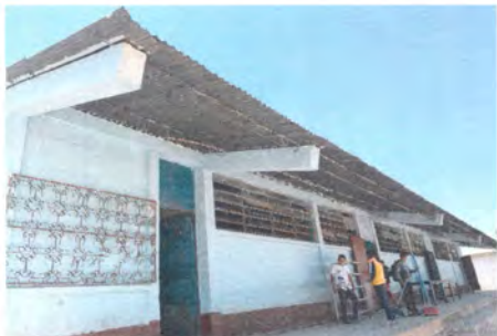
Foto1: Pintado de paredes
