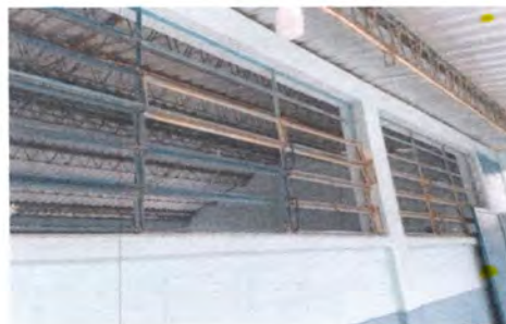
Foto 6: Reparación de muro perimetral
