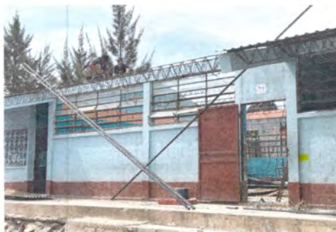
FOTO 2: Pintado de Paredes
