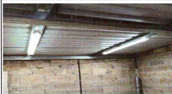
Foto 5: INSTALACION DEL SISTEMA ELECTRICO
