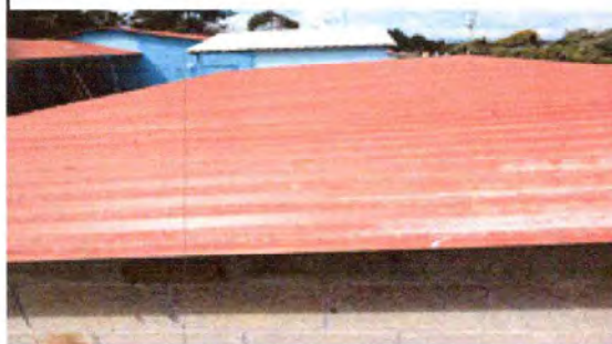
Foto 2: TECHO EN EL AULA INSTALADO
