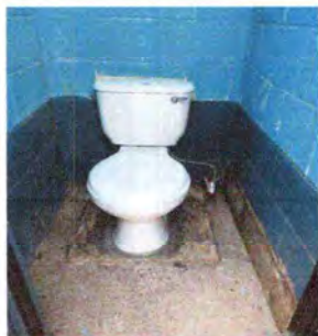
Foto 5: SERVICIOS SANITARIOS REPARADOS
