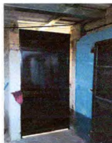
Foto 4: PUERTA INSTALADA Y REPARADA EN LA COCINA
