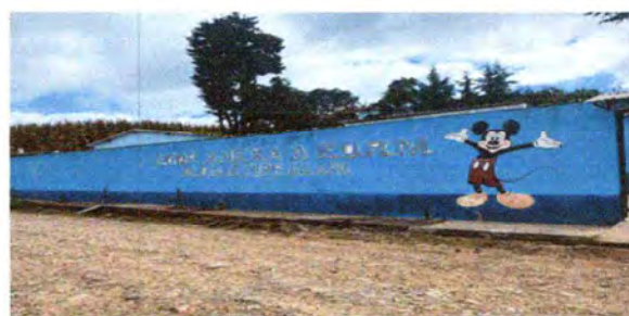
Foto 6: PINTURA DE MUROS EXTERIORES EN LA ESCUELA
