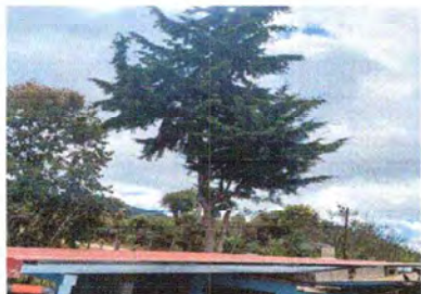
Foto 1: TECHO EN LA COCINA INSTALADO
