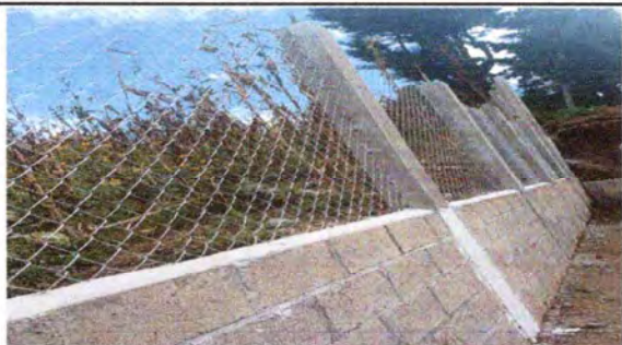
Foto 1: CERCO O MURO PERIMETRAL TERMINADO
