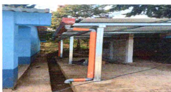
Foto 4: INSTALACIÓN DE CANALES Y BAJADAS DE AGUA
