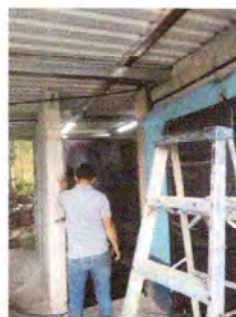
Foto 4: sustitución y reparación de puerta en la cocina
