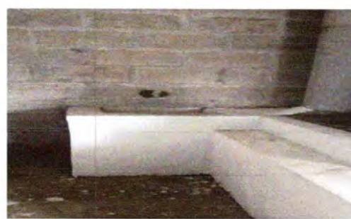
Foto 2: reparación de COCINA
