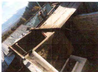
Foto1: sustitucion de techo en cocina
