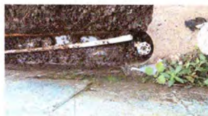
Foto 6: REPARACION DE RED DE AGUA POTABLE
