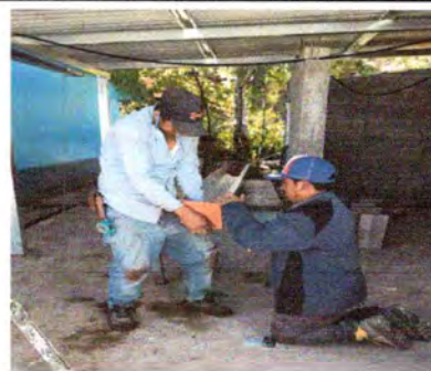
Foto 4: sustitución de bajadas de agua o canal
