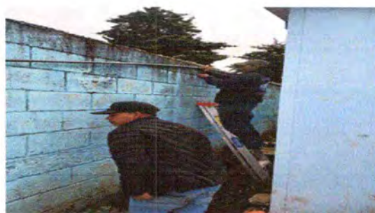
Foto 5: REPARACION Y SUSTITUCION DEL SISTEMA ELECTRICICO
