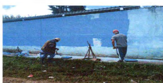
Foto 6: PINTURA EN MUROS EXTERIORES
