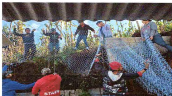
Foto1: sustitucion de cerco o muro perimetral
