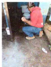
Foto 5: Sustitucion y reparacion de servicios sanitarios
