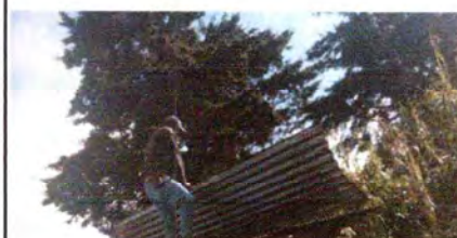
Foto 2: sustitución de techo de una aula
