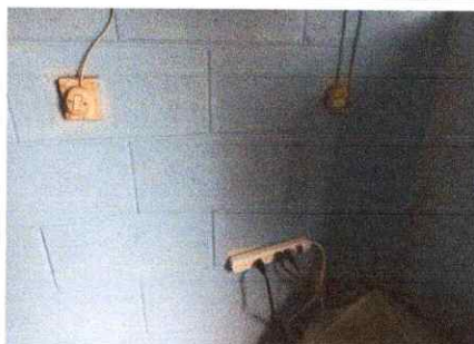
Foto 5: REPARACION DEL SISTEMA ELECTRICO
