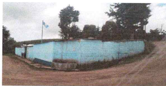
Foto 6: PINTURA DE MUROS EXTERIORES
