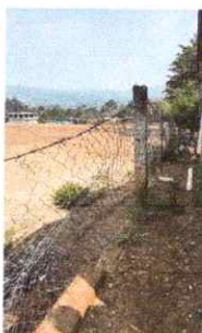
Foto 1: CERCO O MURO PERIMETRAL
