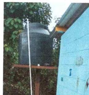
Foto 6: REPARACION DE RED DE AGUA POTABLE
