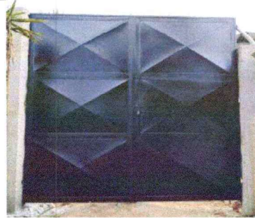
Foto 2: SUSTITUCIÓN DE PORTÓN DE TUBO CON LAMINA LISA
