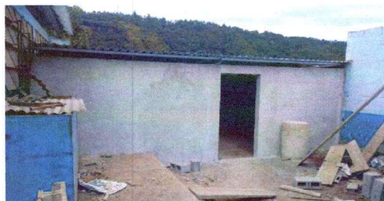
Foto 6: SUSTITUCIÓN DE ESTRUCTURA DE TECHO
