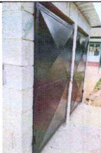
Foto 3: SUSTITUCIÓN DE SANITARIO COMPLETO
