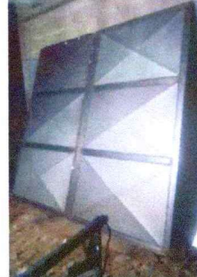
Foto 2: SUSTITUCIÓN DE PORTÓN DE TUBO CON LAMINA LISA
