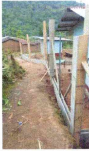
Foto 1: SUSTITUCIÓN DE CERCO PERIMETRAL CON BLOCK Y MALLA
