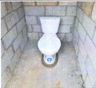
Foto 3: SUSTITUCIÓN DE SANITARIO COMPLETO
