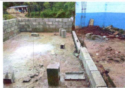
Foto 4: SUSTITUCIÓN DE MURO DE CONCRETO ARMADO
