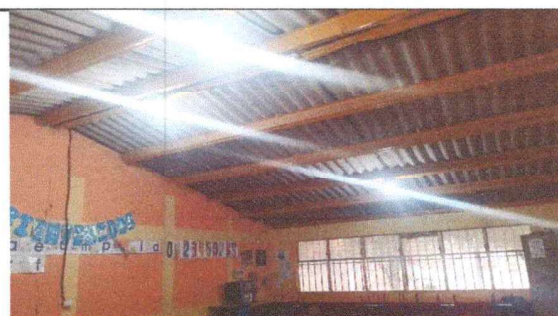
Foto 6: REPARACIÓN DE SISTEMA ELÉCTRICO
