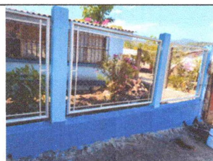
Foto 5: CERCO O MURO PERIMETRAL
