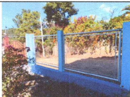
Foto 3: PINTURA DE MUROS INTERIOR Y EXTERIOR
