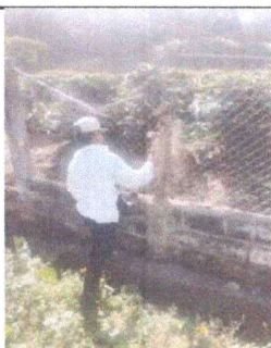
Foto 3: CERCO O MURO PERIMETRAL
