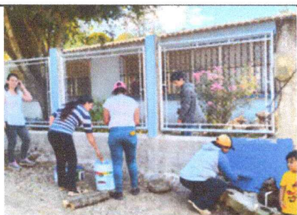
Foto 5: PINTURA DE MUROS INTERIOR Y EXTERIOR
