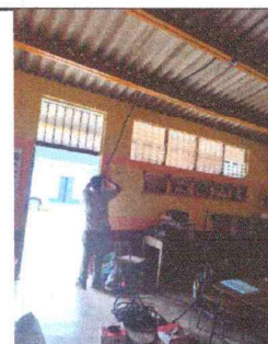
Foto 6: REPARACIÓN DE SISTEMA ELÉCTRICO
