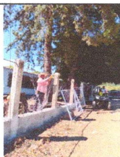
Foto 4: CERCO O MURO PERIMETRAL
