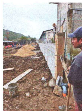
muro de contencion al final de la escuela
