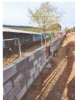
muro de contencion al frente de la escuela
