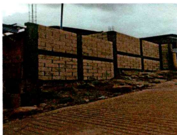
Foto 5: muro de contención reparado
