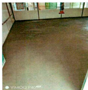
Foto 2: remodelación de grietas en torta de aula
