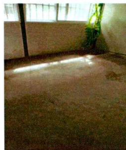
Foto 4: remodelación de grietas en torta de aula
