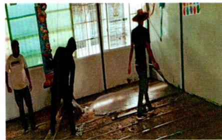
Foto 4: renovacion de grietas en torta de aula
