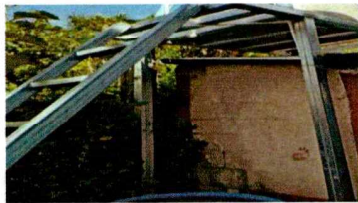
Foto 3: renovación de depósito de agua y base.
