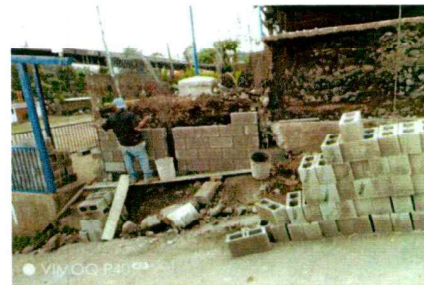
Foto 6: Renovación en muro de contención
