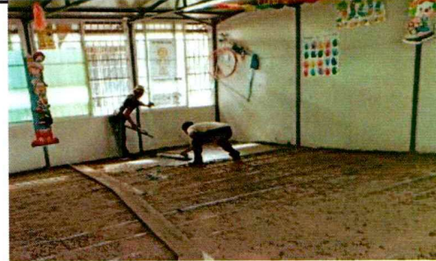
Foto 2: renovacion de grietas en torta de aula
