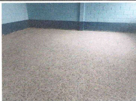
Foto 4: SUSTITUCIÓN DE PISO DE GRANITO (INCLUYE BASE CON MEZCLON)
