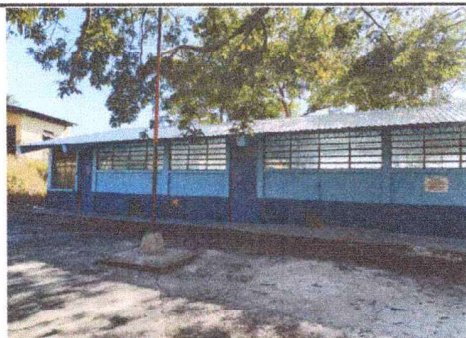
Foto 5: PINTURA EN MUROS INTERIOR Y EXTERIOR
