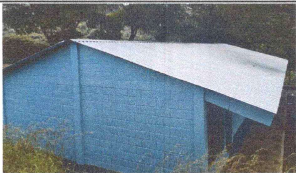
Foto1: SUSTITUCIÓN DE LÁMINA TROQUELADA CALIBRE 26
