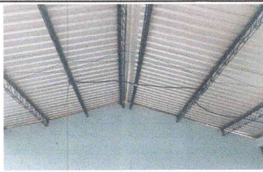
Foto 2: REPARACIÓN Y MANTENIMIENTO DE ESTRUCTURA DE TECHO
