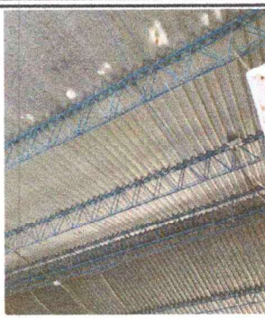
Foto 2: REPARACIÓN Y MANTENIMIENTO DE ESTRUCTURA DE TECHO
