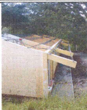
Foto1: SUSTITUCIÓN DE LÁMINA TROQUELADA CALIBRE 26
