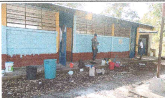
Foto 5: PINTURA EN MUROS INTERIOR Y EXTERIOR
