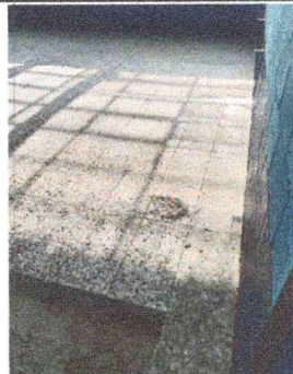
Foto 4: SUSTITUCIÓN DE PISO DE GRANITO (INCLUYE BASE CON MEZCLON)
