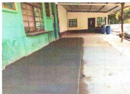
Foto1: SUSTITUCION PISO DE CEMENTO (DEMOLICION DE RESTOS, BASE, FUNDICION MAS ACABADO)
