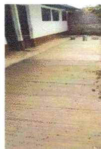
Foto 4: SUSTITUCIÓN LOSA DE PATIO INCLUYE, BASE, FUNDICION Y ACABADO
