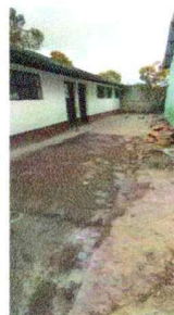
Foto 4: SUSTITUCIÓN LOSA DE PATIO INCLUYE, BASE, FUNDICION Y ACABADO
