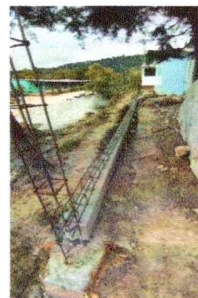
Foto 2: SUSTITUCIÓN DE CERCO PERIMETRAL CON BLOCK Y MALLA (MITAD BLOCK Y MITAD MALLA)
