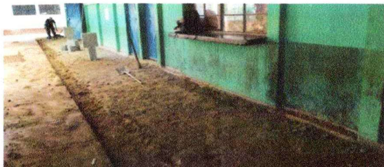
Foto1: SUSTITUCION PISO DE CEMENTO (DEMOLICION DE RESTOS, BASE, FUNDICION MAS ACABADO)
