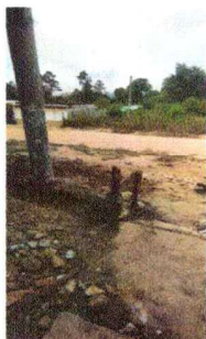
Foto 3: REPARACION Y MANTENIMIENTO A PORTON
