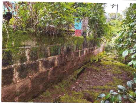
Foto 2: Se observa la necesidad de cambiar completamente el muro de la parte de atrás, presente socavación por agua y se debe evitar el riesgo que se caiga y ocasione accidentes a los vecinos y alumnos.
