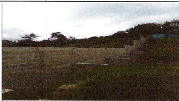
Foto 2: MURO PERIMETRAL CONCLUIDO
