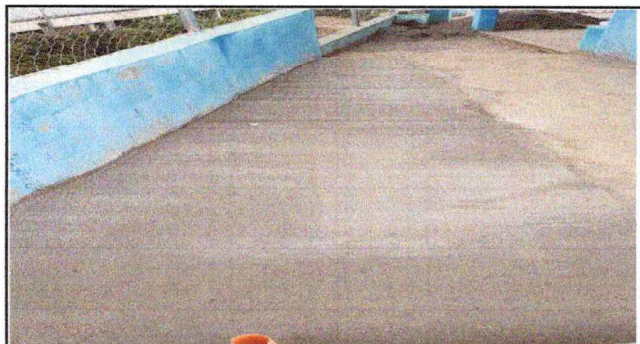
Foto 3: SUSTITUCION LOSA DE PATIO TERMINADA
