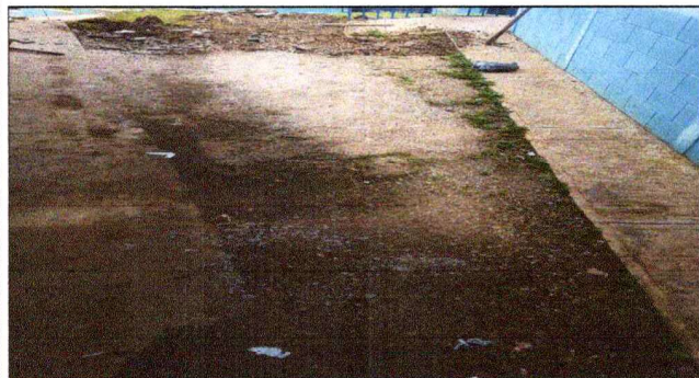
Foto 3: LOSA DE PATIO EN PREPARACION PARA SU FUNDICION
