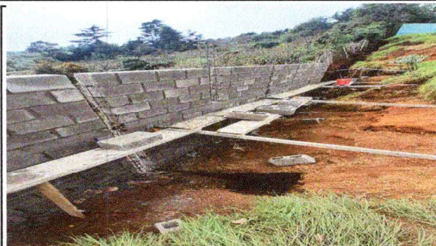
Foto 2: MURO PERIMETRAL EN PROCESO DE CONSTRUCCION
