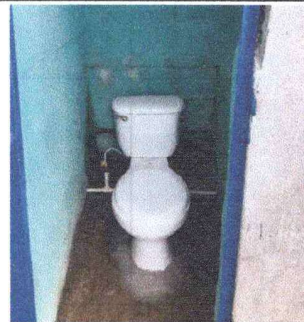
Foto 4: Cambio de sanitarios finalizado
