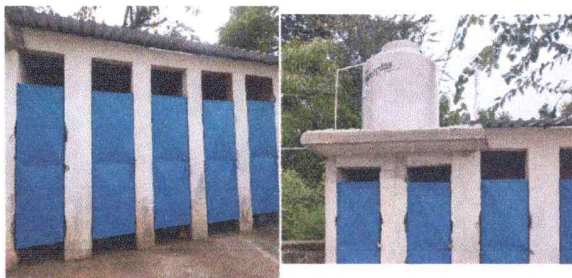
Foto 5: Cambio de Puertas de sanitarios finalizado
