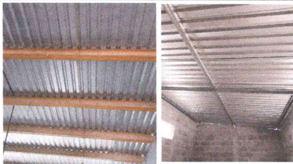
Foto 3: Cambio de dache de duralita por lamina troquelada finalizado
