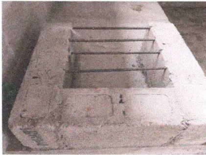
Foto 1: Remodelación del Area para cocinar finalizado
