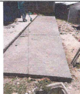
Foto 6: Losa de patio finalizado
