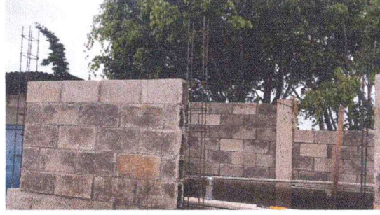
Foto 2: Paredes de cocina en remodelación
