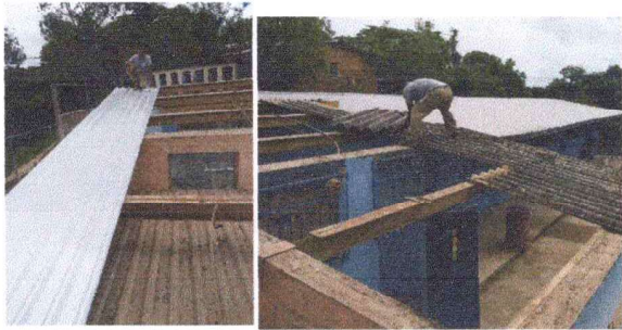
Foto 3: Cambio de techo de duralita en proceso
