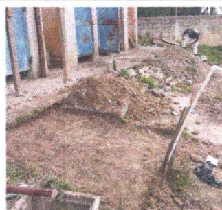
Foto 6: Cambio de losa de patio en proceso
