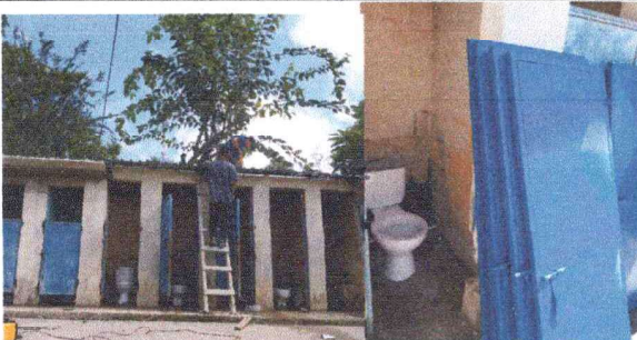
Foto 5: Cambio de Puertas de sanitarios en proceso
