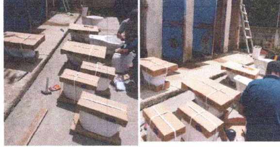
Foto 4: Cambio de sanitarios en proceso
