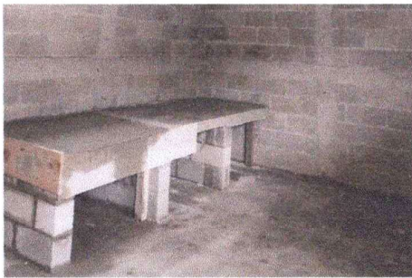
Foto 1: Área para cocinar en remodelación
