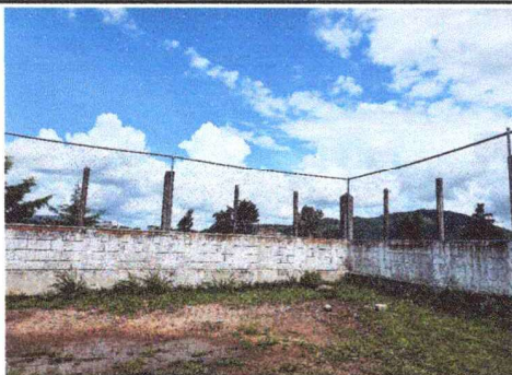
Foto3: REPARACIÓN DE MURO PERIMETRAL DE ESTRUCTURA METALICA (MALLA EN MÓDULOS)
