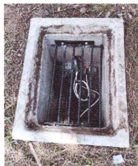
Foto4: REPARACIÓN DE SITEMA ELÉCTRICO, REINSTALACIÓN SISTEMA ELECTIFICACION DEL RAZOR RIBBON
