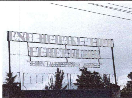
FOTO 2: CERCO O MURO PERIMETRAL, REINSTALACIÓN DE RAZOR RIBBON
