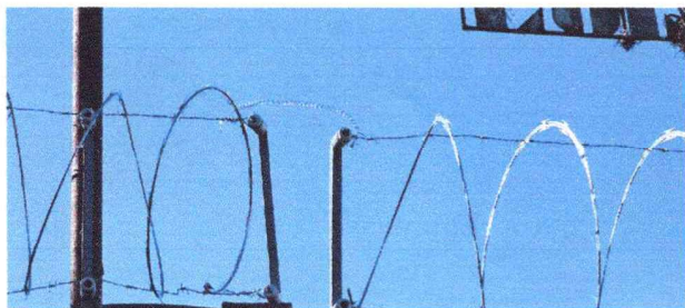
Foto1: CERCO O MURO PERIMETRAL, REINSTALACIÓN DE RAZOR RIBBON
