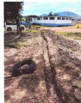
Foto4: REPARACIÓN DE SITEMA ELÉCTRICO, REINSTALACIÓN SISTEMA ELECTIFICACION DEL RAZOR RIBBON
