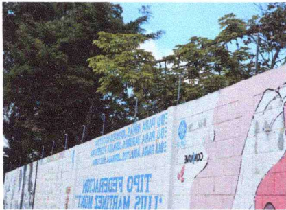
Foto1: CERCO O MURO PERIMETRAL, REINSTALACIÓN DE RAZOR RIBBON
