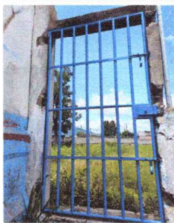
Foto 5: PUERTA DE METAL CON CHAPA YALE
