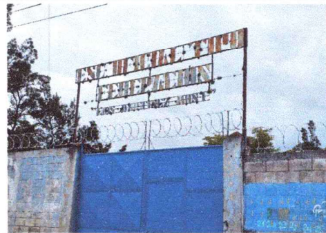
FOTO 2: CERCO O MURO PERIMETRAL, REINSTALACIÓN DE RAZOR RIBBON
