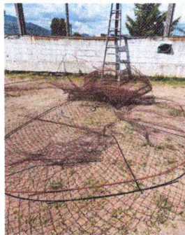
Foto3: REPARACIÓN DE MURO PERIMETRAL DE ESTRUCTURA METALICA (MALLA EN MODULOS)
