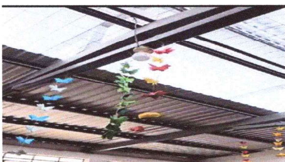
Foto: 5 FINALIZACION DEL CAMBIO DE LAMINA
