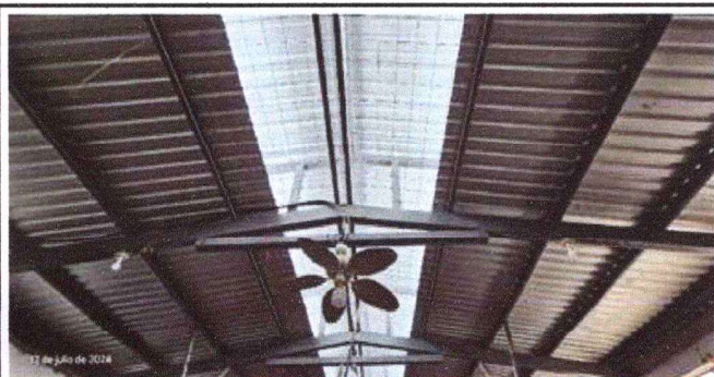
Foto3: DETALLE CONSTRUIDO PARA LA VENTILACION EN LAS AULAS
