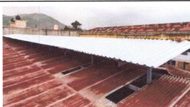
Foto4: INSTALACION DE CAPOTE
