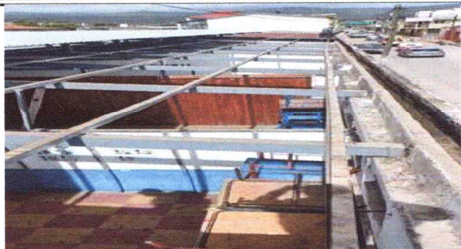
Foto1: SUSTITUCION DE LAMINA EXISTENTE POR LAMINA ACANALA CALIBRE No. 26
