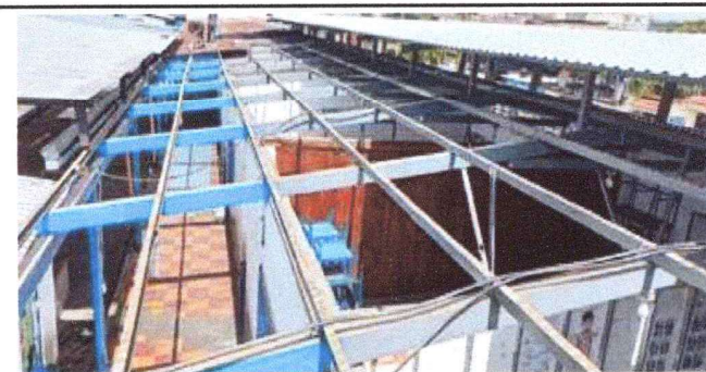
Foto: 5 CAMBIO DE LAMINA EXISTENTE DAÑADA
