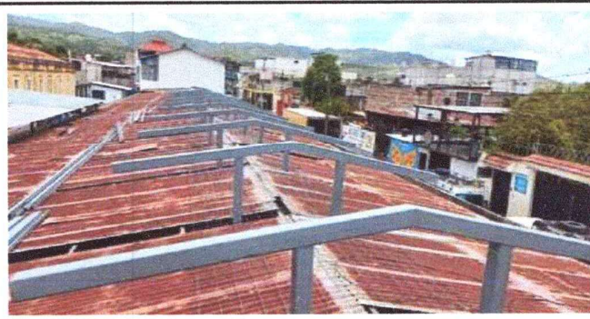
FOTO 2: INSTALACION DE ESTRUCTURA METALICA PARA ELEVAR EL TECHO.
