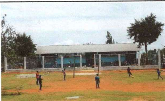
Foto 3: REPARACION DE MURO PERIMETRAL DE BLOCK CON MALLA GALVANIZADA Y TUBO HG, SOLERAS INTERMEDIAS Y COLUMNAS
