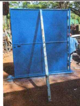
Foto 2: SUSTITUCION DE PORTON DE LA ENTRADA PRINCIPAL
