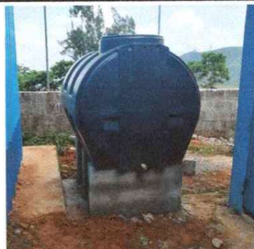
Foto 4: INSTALACION DE DEPOSITO PARA AGUA
