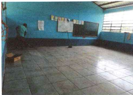
Foto1: SUSTITUCION DE PISO
