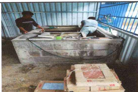
Foto 5: REPARACION E INSTALACION DE AZULEJO EN PILA
