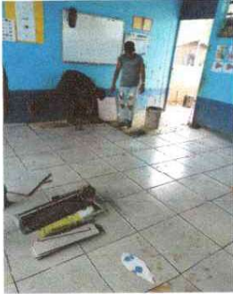
Foto 1: SUSTITUCION DE PISO
