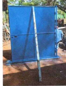
Foto 2: SUSTITUCION DE PORTON DE LA ENTRADA PRINCIPAL
