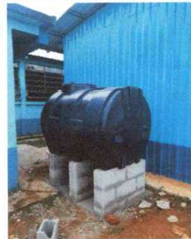
Foto 4: INSTALACION DE DEPOSITO PARA AGUA
