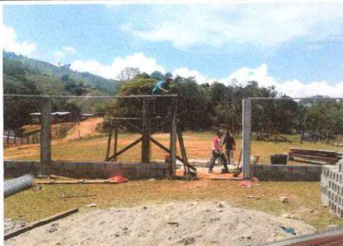
Foto 3: REPARACION DE MURO PERIMETRAL DE BLOCK CON MALLA GALVANIZADA Y TUBO HG, SOLERAS INTERMEDIAS Y COLUMNAS
