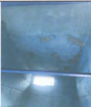
Impermeabilización de losa
