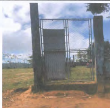
Sustitución de porton de la entrada principal
