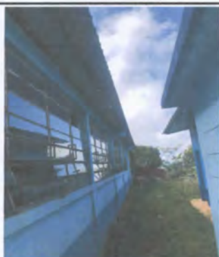
Sustitución de canal de pvc
