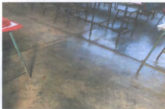
Sustitución de piso de granito
