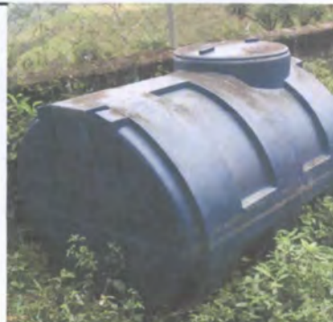
Instalación de depósito para agua
