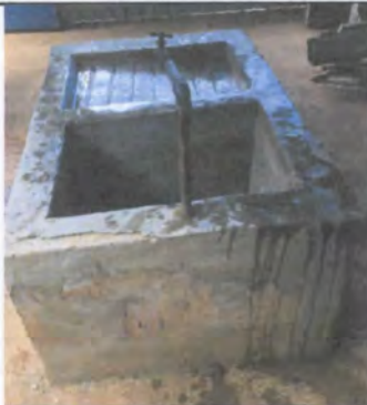
Reparación e instalación de azulejo en pila
