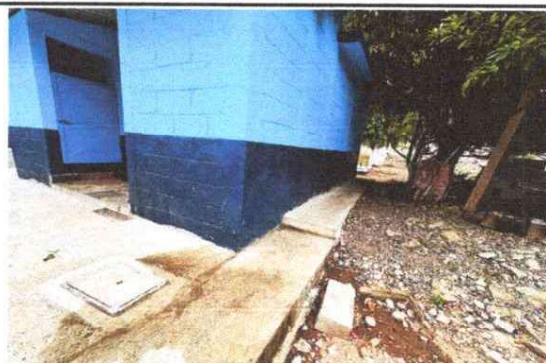
REPARACIÓN DE RED DE DRENAJE
