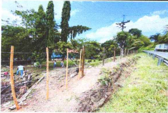
REPARACIÓN DE CERCO DE ALAMBRE DE PÚA
