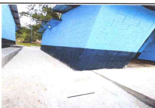
REPARACIÓN RED DE AGUA POTABLE
