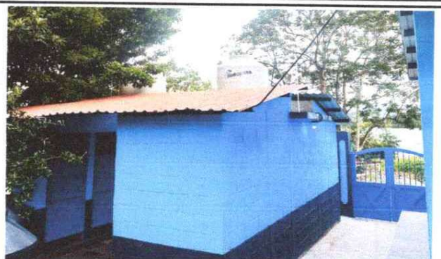
REPARACIÓN Y MANTENIMIENTO DE CISTERNAS/DEPÓSITOS DE AGUA
