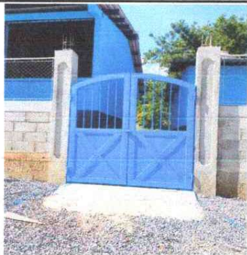
SUSTITUCIÓN DE PORTÓN DE METAL
