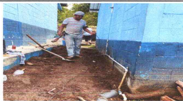
REPARACIÓN RED DE AGUA POTABLE
