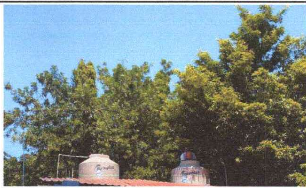
REPARACIÓN Y MANTENIMIENTO DE CISTERNAS/DEPÓSITOS DE AGUA
