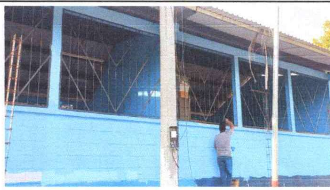
PINTURA EN MUROS EXTERIORES E INTERIORES
