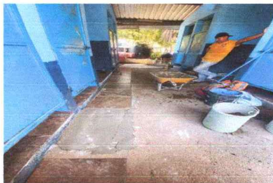
SUSTITUCIÓN DE PISO
