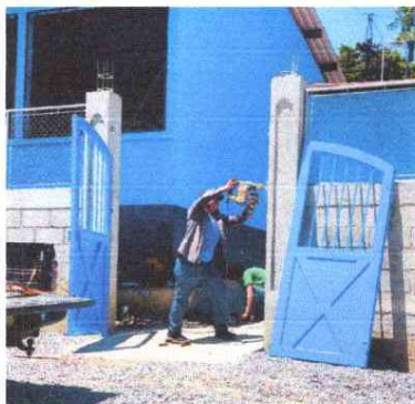
SUSTITUCIÓN DE PORTÓN DE METAL
