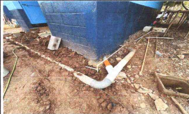
REPARACIÓN DE RED DE DRENAJE
