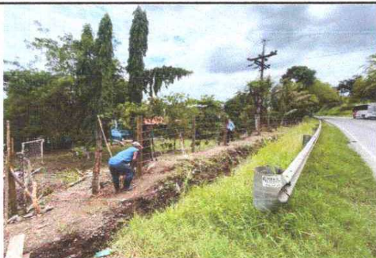
REPARACIÓN DE CERCO DE ALAMBRE DE PÚA
